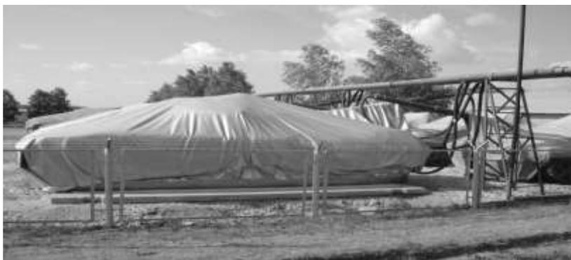
*Рисунок 6.– Гермоукрытие бескаркасного типа*
