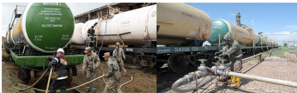
Рисунок 1. Работа по перекачки компонента ракетного топлива «Меланж»
