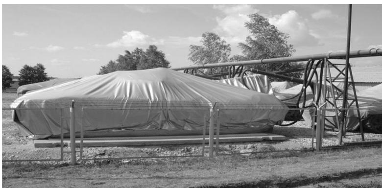
*Рисунок 6. – Гермоукрытие бескаркасного типа*
